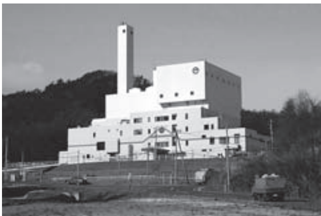
町の一般廃棄物を処理している滝沢村清掃センター
