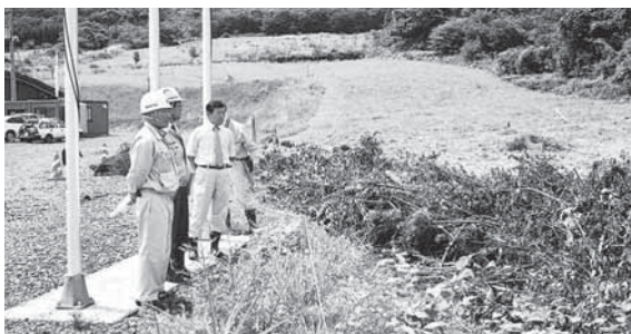
町営クロスカントリースキー場の駐車場造成工事を調査する委員
