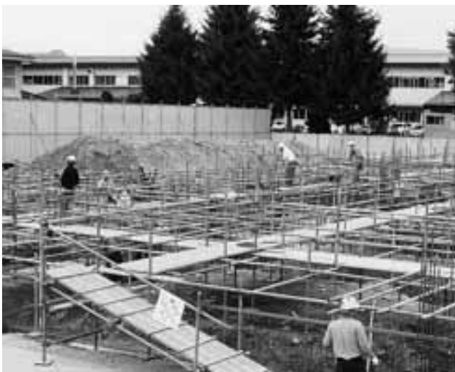
校舎改築が進む安庭小学校の工事現場
