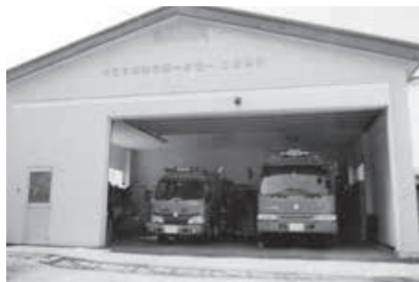
防災拠点の第1分団1・2部屯所
