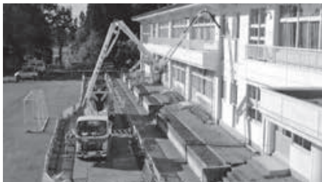
工事費の大幅増額が見込まれる栗石小トイレ改修工事
