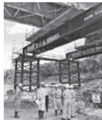
西長橋の工事を視察する委員
