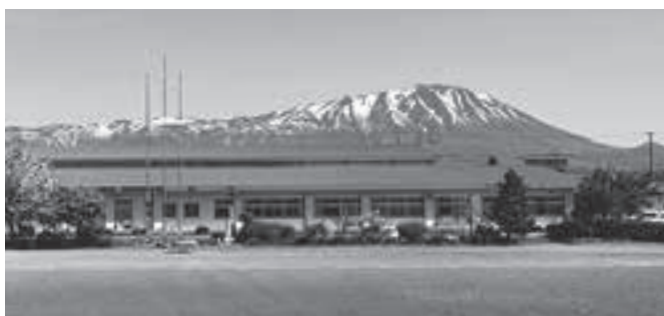
改修工事が始まる御明神小学校
