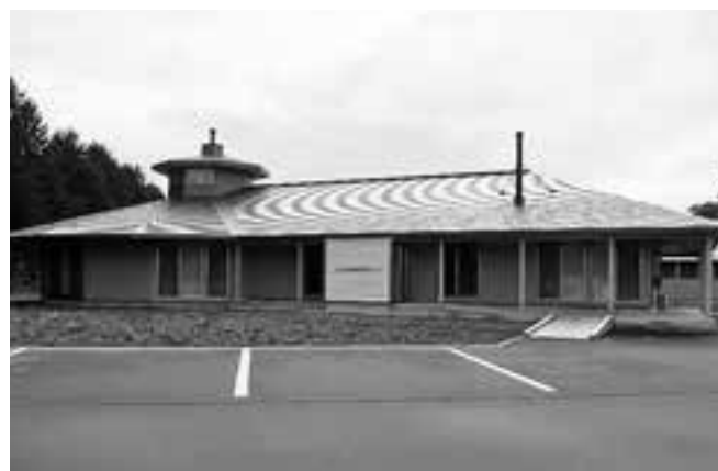
完成した七ツ森地域交流センター
