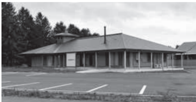
照明設置工事予定の七ツ森地域交流センター
