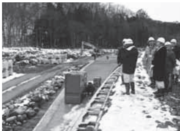
完成が待たれる、小赤沢地区の河川災害復旧工事
