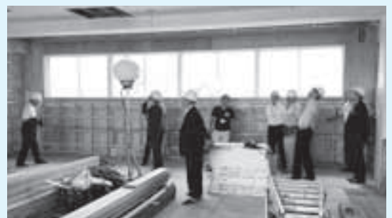
改修工事が進む中学校
