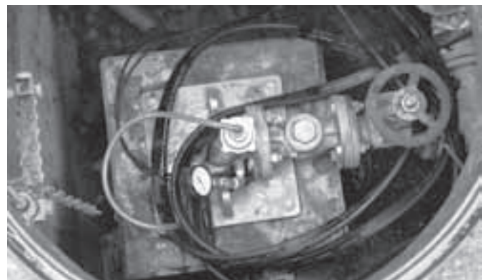
交換した、道の駅源泉吸い上げポンプ
