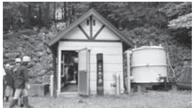
鶯宿温泉旭の湯源泉ポンプ場
