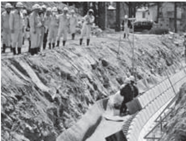
災害復旧工事現場
