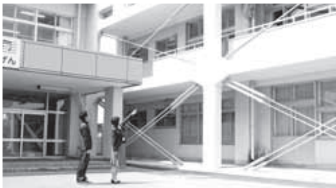
完成した雫石中学校耐震工事
