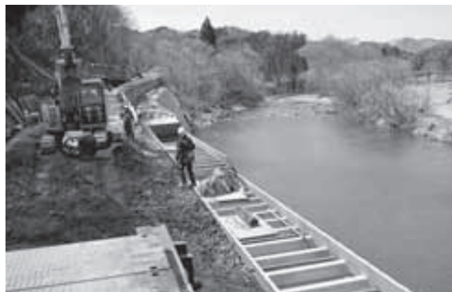
河川災害復旧工事が進む工事現場
