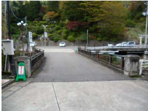
鶯宿橋 起点側
