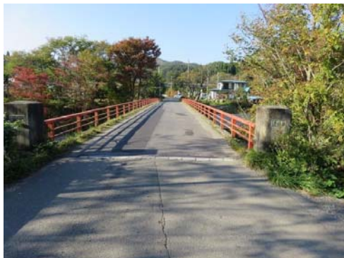
昇瀬橋 起点側
