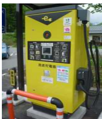
写真 7 電気自動車用急速充電器
