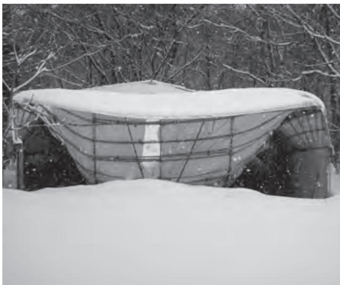
大雪により損壊したビニールハウス
