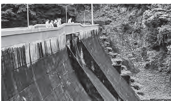
防災ダム群の一つ、レン滝ダム
