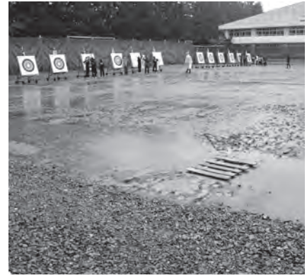
雨天に備え側溝を整備予定のアーチェリーセンター
