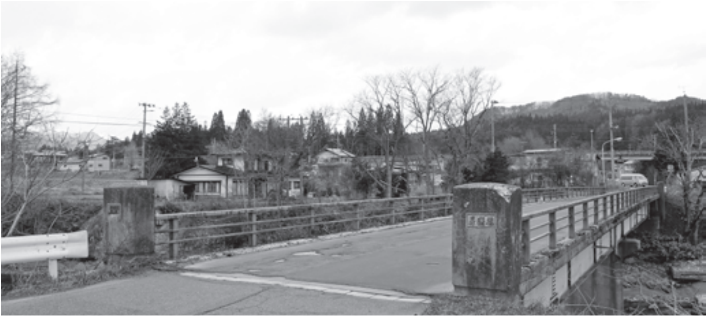
いよいよ着手、昇瀬橋架け替え
