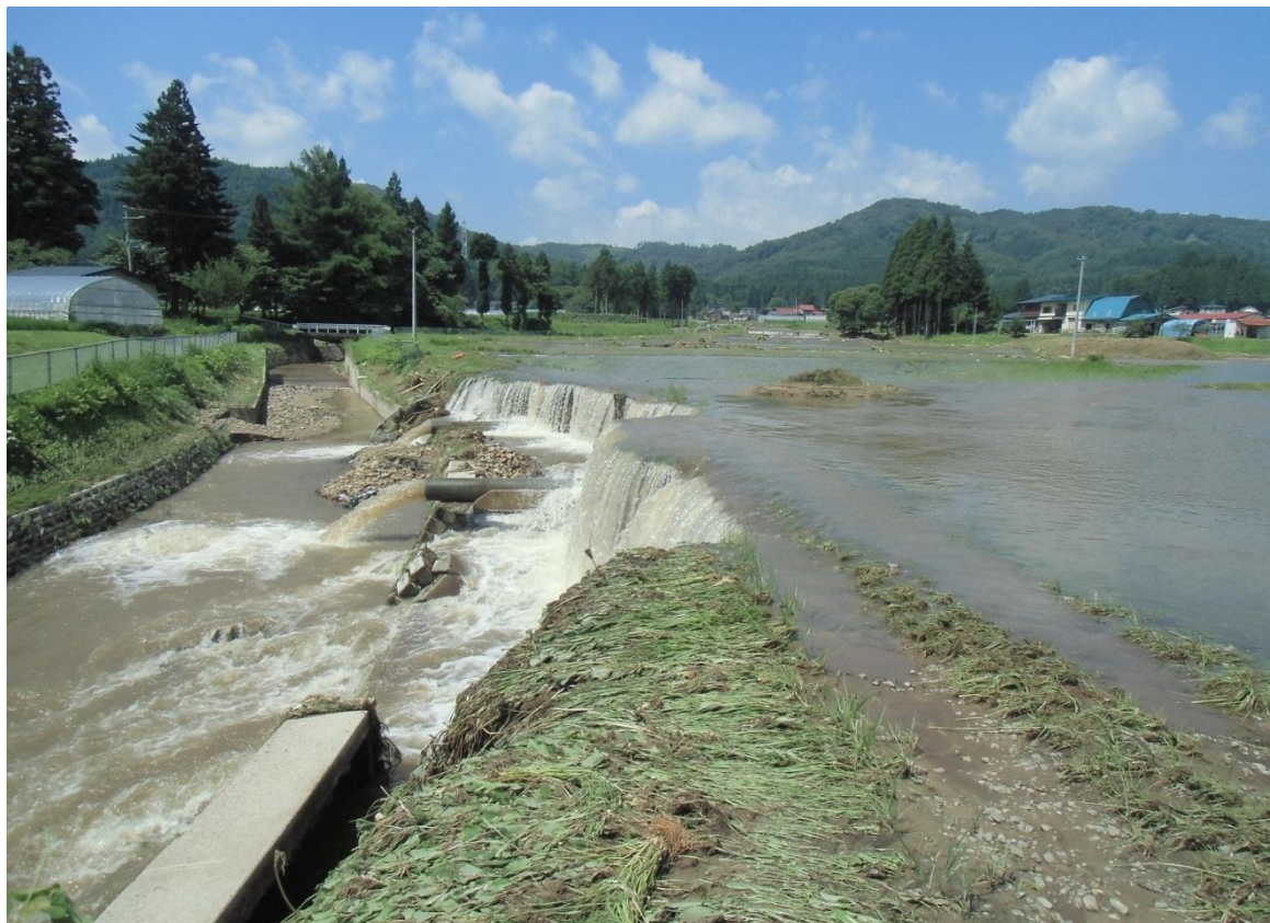
農地被害状況（法面崩壊）
