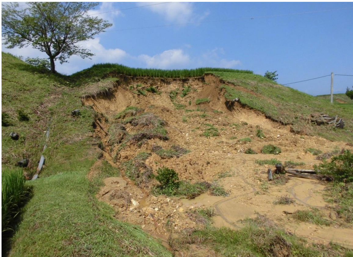
農地被害状況（法面崩壊）
